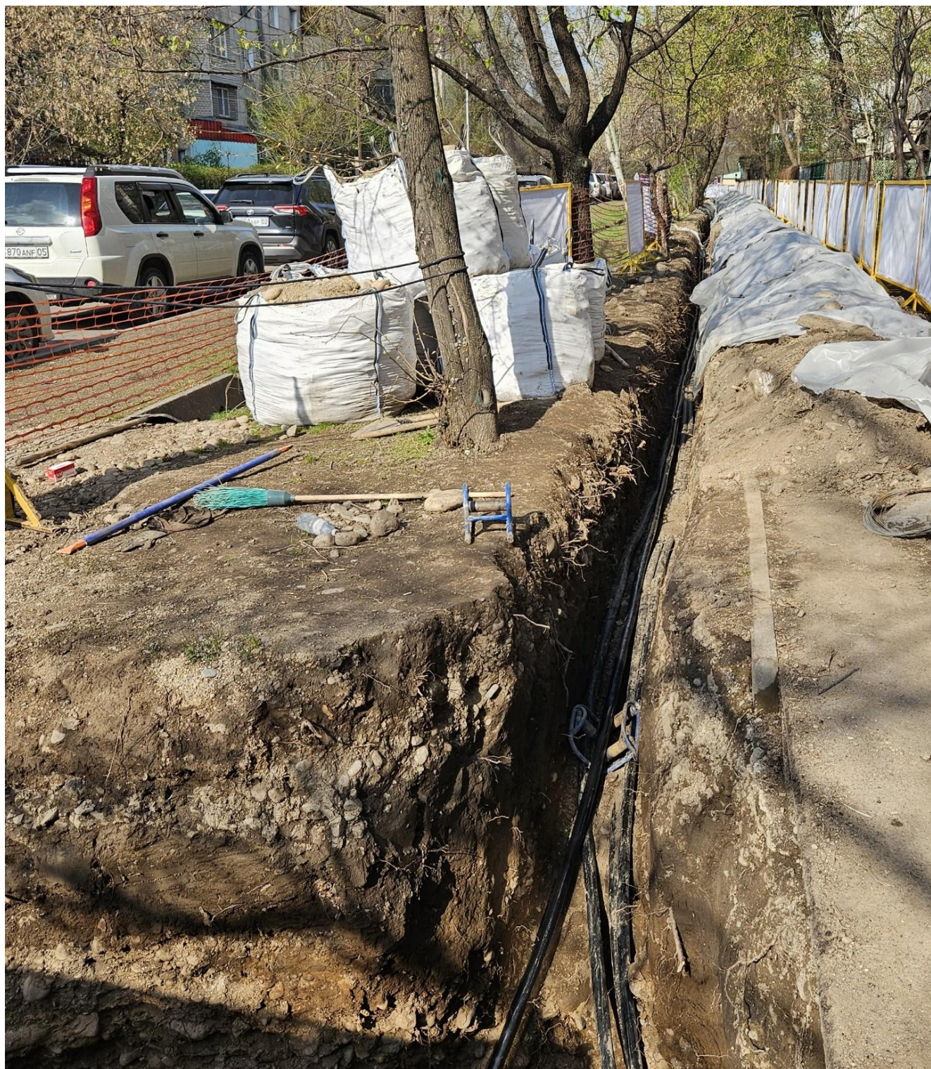
Прокладка силового кабеля по ул.Габдулина угол ул.Р.Корсакова.
